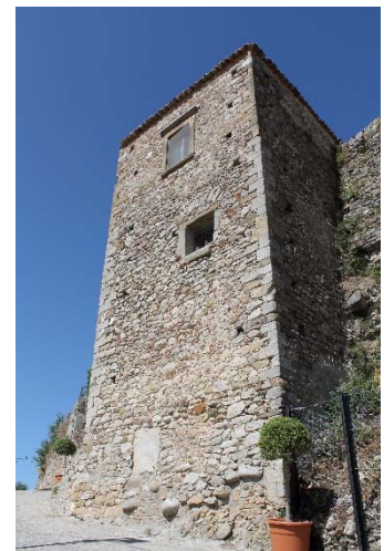
Figura 11 Castello, mura medioevali, torre est
